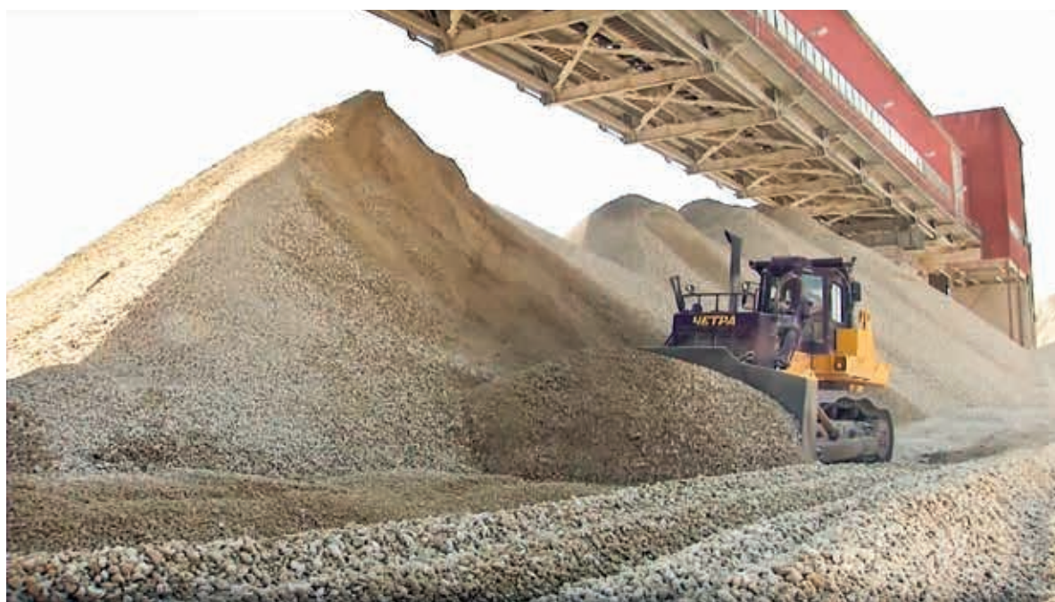
◀ На снимке: мощный бульдозер ЧЕТРА Т25 теперь работает в цехе обжига извести ОЭМК
