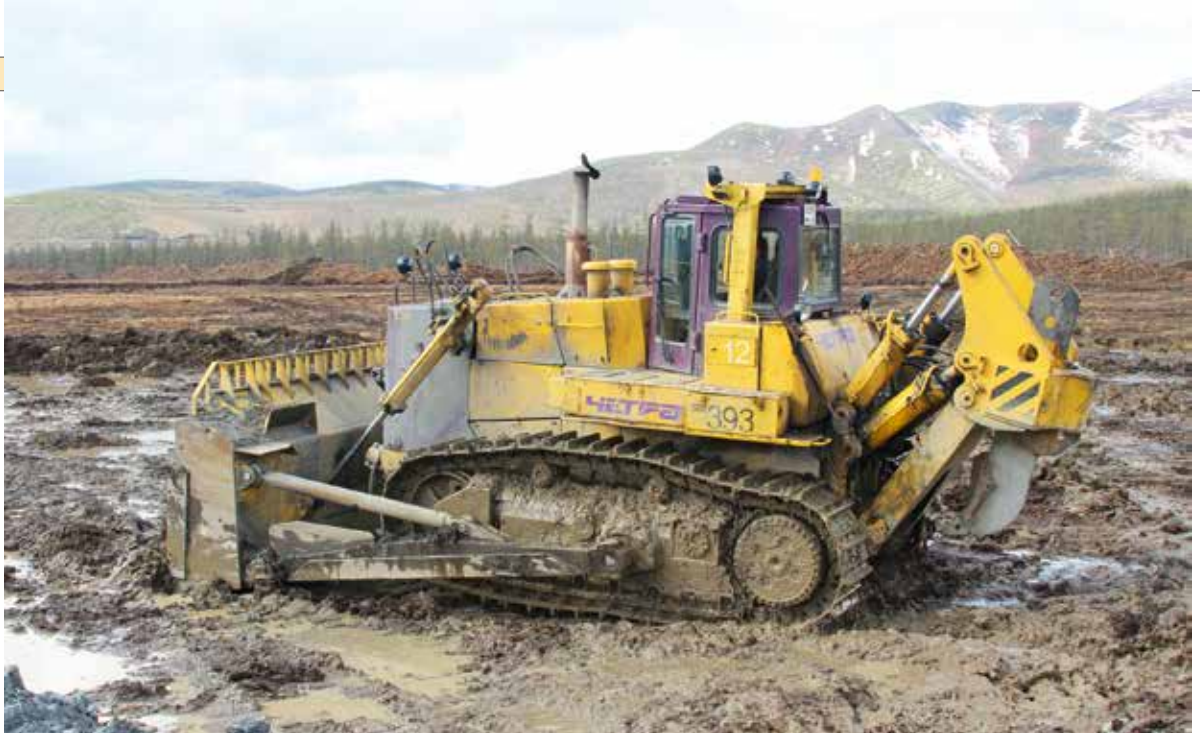
▲ На снимке: бульдозеры ЧЕТРА на вскрышных работах
