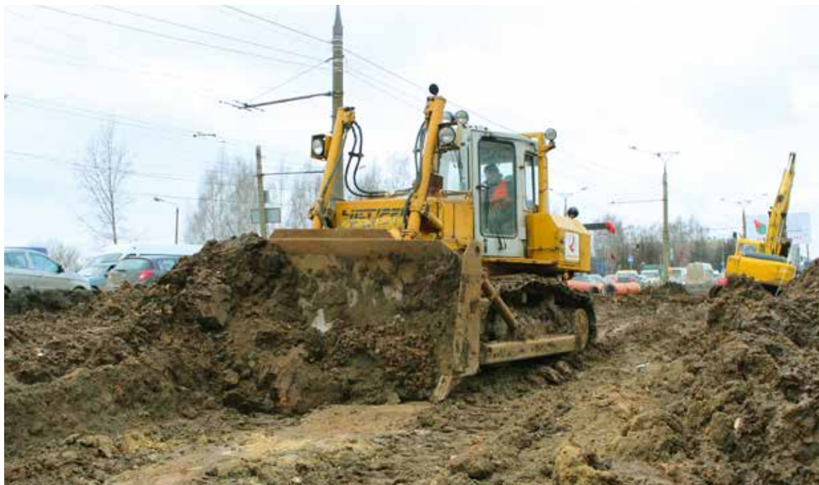
▲ На снимке: реконструкция проспекта имени И. Яковлева в г. Чебоксары идет полным ходом
