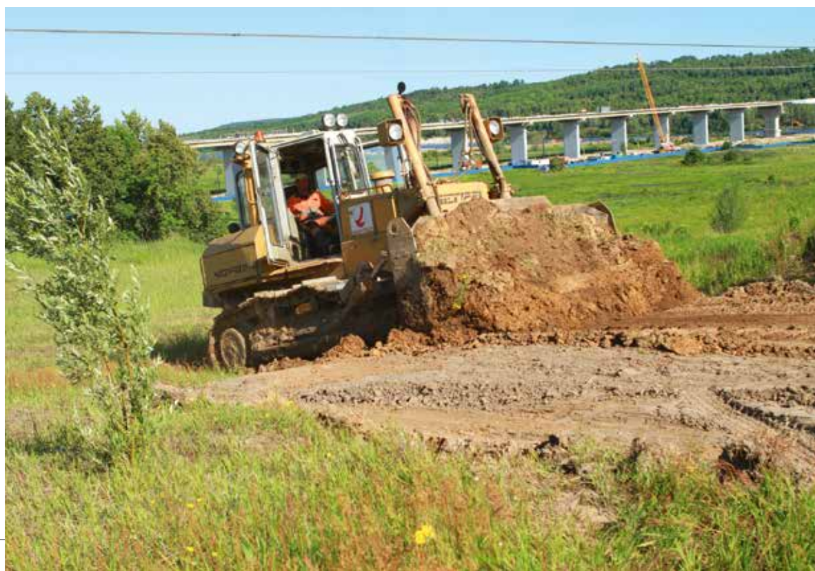
◀ На снимке: ЧЕТРА Т11 на строительстве моста через реку Сура (федеральная трасса М-7)
