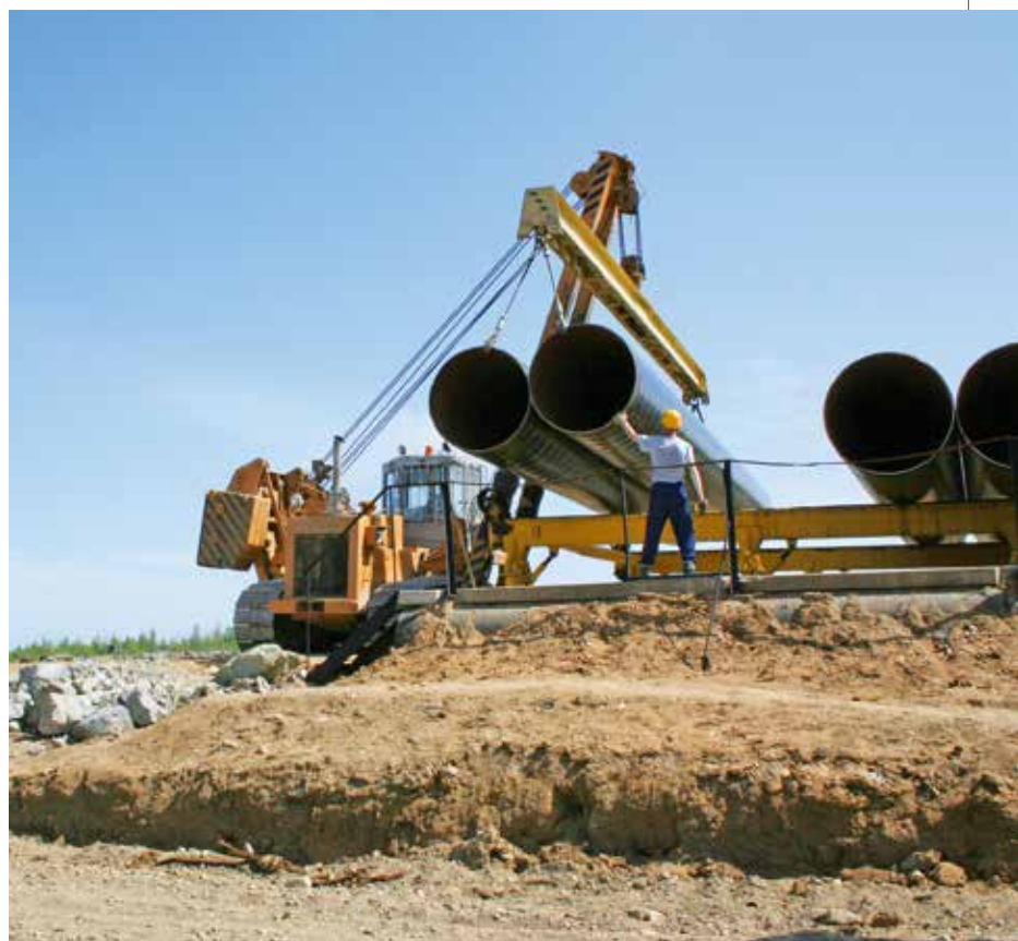
▲ На снимке: трубоукладчики ЧЕТРА на строительстве ВСТО
