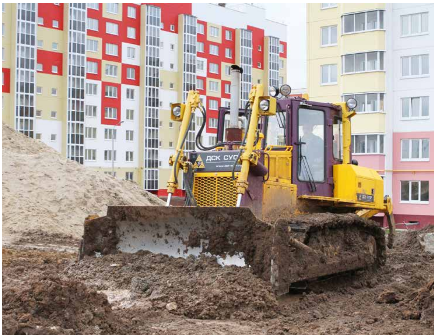
▲ На снимке: ЧЕТРА Т9 на строительстве микрорайона «Садовый»
