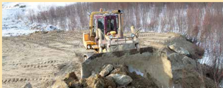
▲ На снимке: бульдозер ЧЕТРА Т20.02 на разработке месторождения золота на Дальнем Востоке
