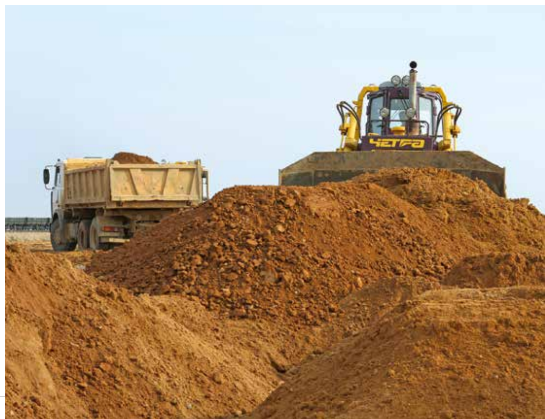
На снимке: ▶ ЧЕТРА Т20 на строительстве Белорусской АЭС
