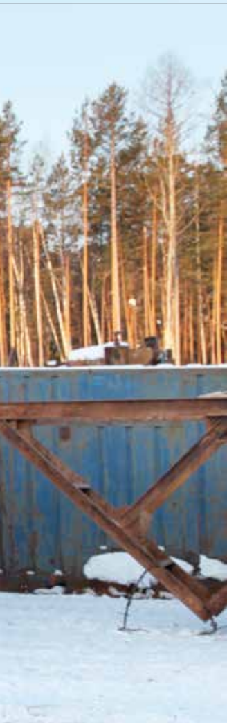
◀ На снимке: трубокладчик ЧЕТРА ТГ 221 на монтаже буровой скважины
