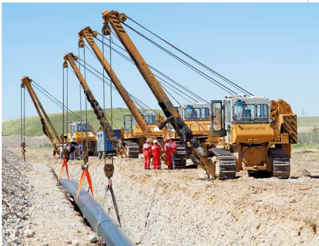
На снимке: ▶ строится газопровод
